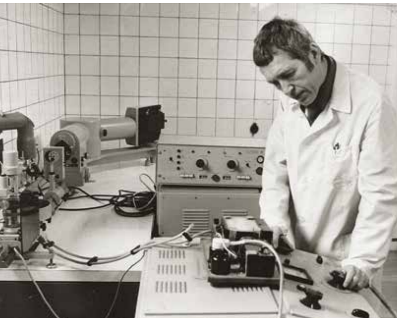
Obr. 5 Jindřich Tomek provádějící prvkovou analýzu na UV-spektrografu Q-24.
